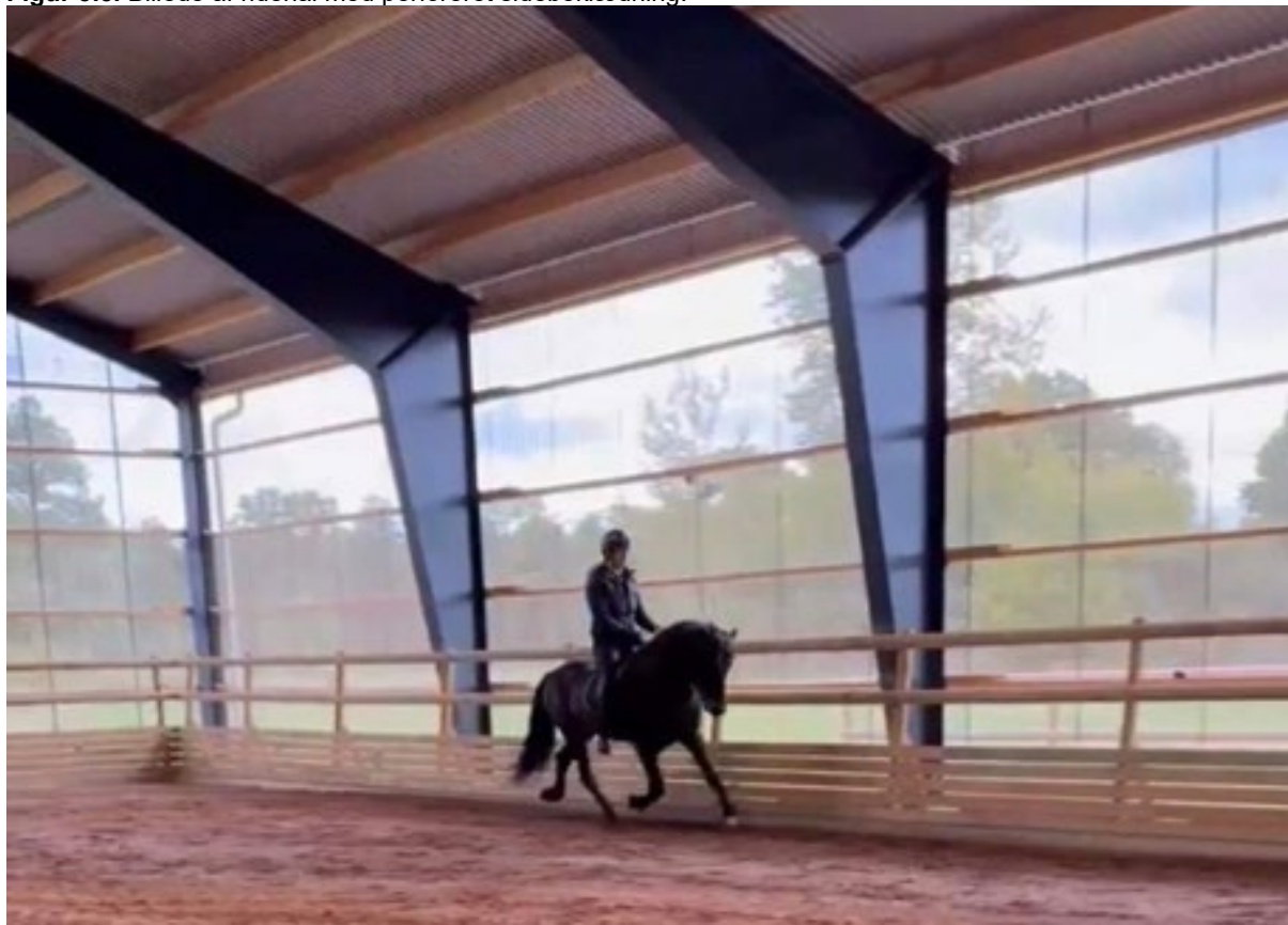
Figur 3.3. Billede af ridehal med perforeret sidebeklædning.
